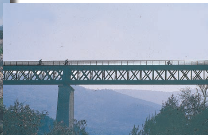
Viaducto en la Vía Verde del Aceite, en la provincia de Jaén.
